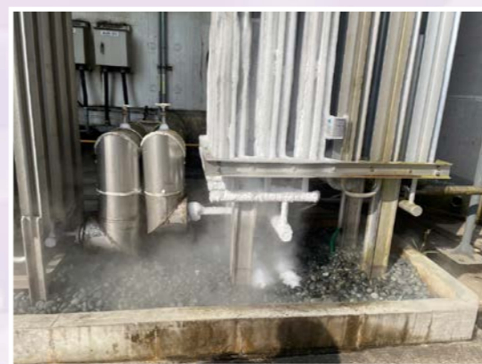
蒸發器運作會吸收大量熱能造成週邊結冰產生低溫水蒸氣
