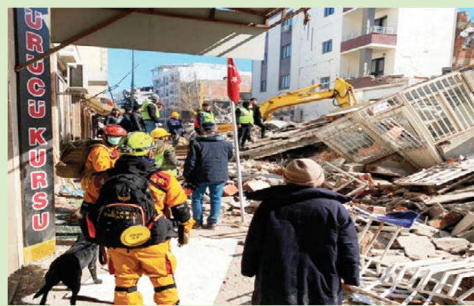
現場建築物倒塌情形
