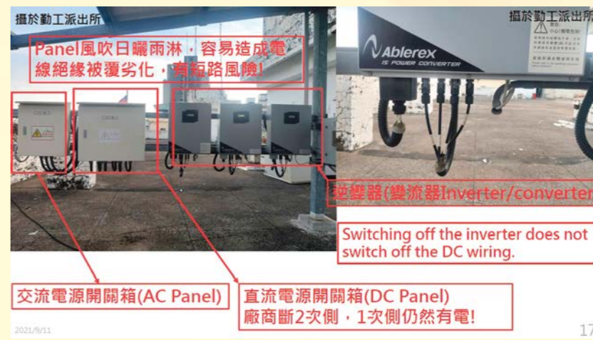
圖6 太陽能發電設備配電線路與構件 (不同場所設置位置不同，自行拍攝)
