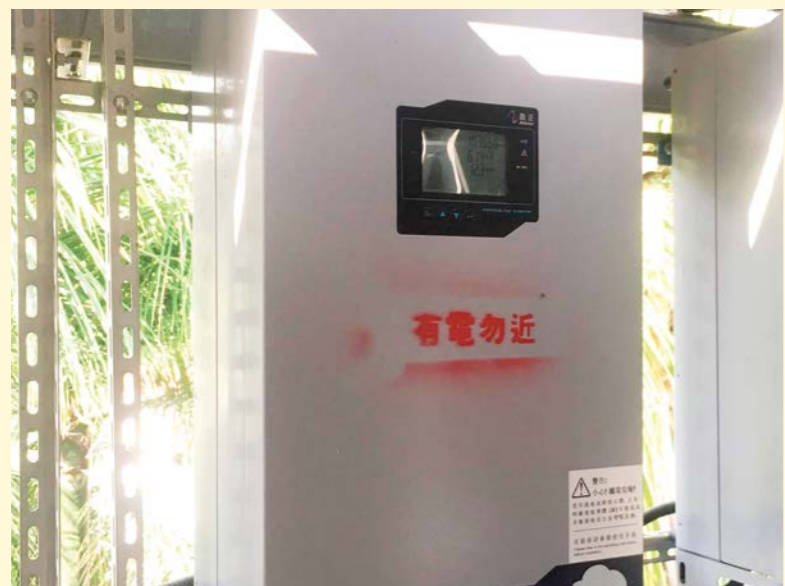
圖2 太陽能發電系統交流逆變器 (各廠牌外觀略有差異，自行拍攝)
