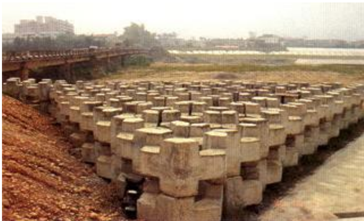
堤防的防護工用來防止洪水的沖蝕
