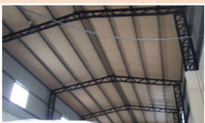
圖三：原辦公室空間改為倉庫使用，應重新檢討設置消防安全設備
