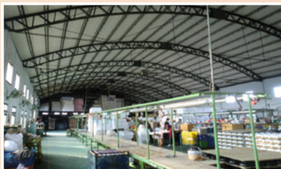
圖二：現場未設排煙設備，應依據使用執照檢討是否應設排煙設備
