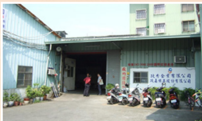
圖一：現場為連棟式鐵皮屋工廠，應合併計算面積檢討設置消防安全設備
