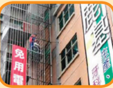
彰基鹿港分院的免電力自走式避難梯
