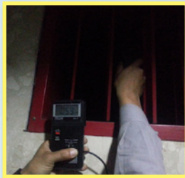
連結送水管測試壓力情形
