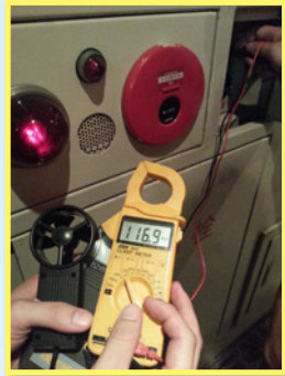
機械式消防專用蓄水池測試情形
