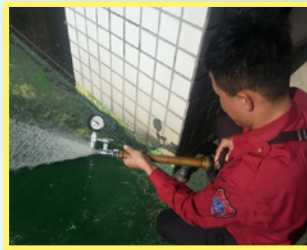
機械式消防專用蓄水池測試情形
