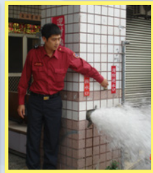
機械式消防專用蓄水池測試情形
