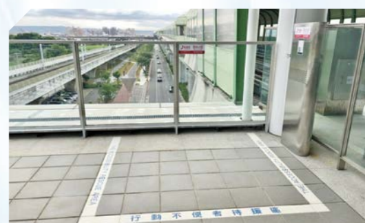
確認行動不便者待援區方位及容留人數空間，以利高空作業昇梯
