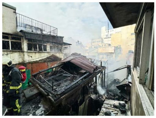
全面燃燒後搶救的狀況
