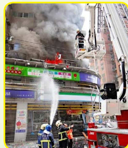
氣爆造成內部天花板垮塌電梯門歪
