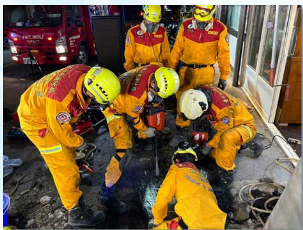
國光分隊使用鑿岩機持續開鑿排水溝涵管，搭配交錯使用軍刀鋸、電動油壓剪切斷鋼筋
