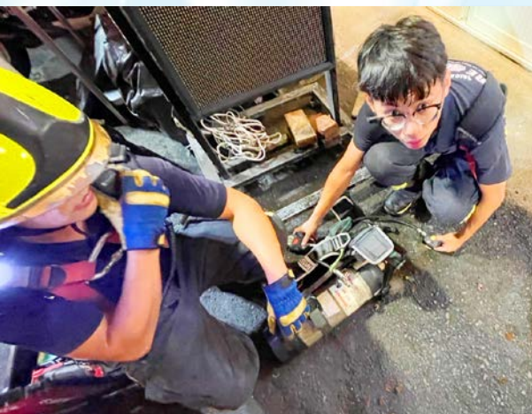
利用SCBA從雨水排入孔，正壓給予空氣提高暗溝內氧氣濃度
