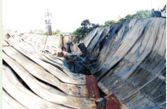
鐵皮工廠火警坍塌情形
