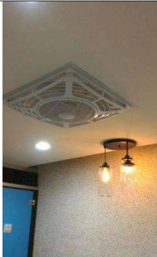
圖 13-5 廁所內採機械換氣，減少廁所臭味。(來源：內政部建築研究所，104)
