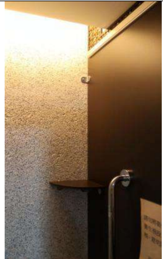
圖 13-6 廁間內設置照明自動感光點滅裝置，以節省電源及如廁安全感。(來源：內政部建築研究所，104)
