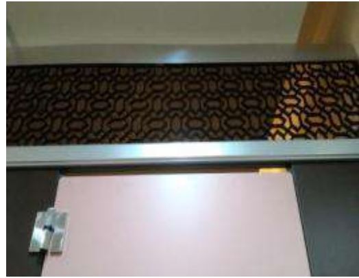
圖 13-4 廁間門板下緣離地面離為 2 公分範圍內，門板上緣離地面應為 210 公分，並考量上緣到天花間之通風及隱密性。(來源：內政部建築研究所，104)
