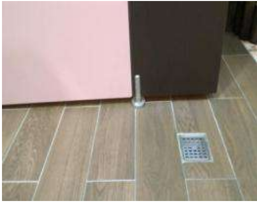
圖 13-4 廁間門板下緣離地面離為 2 公分範圍內，門板上緣離地面應為 210 公分，並考量上緣到天花間之通風及隱密性。(來源：內政部建築研究所，104)
